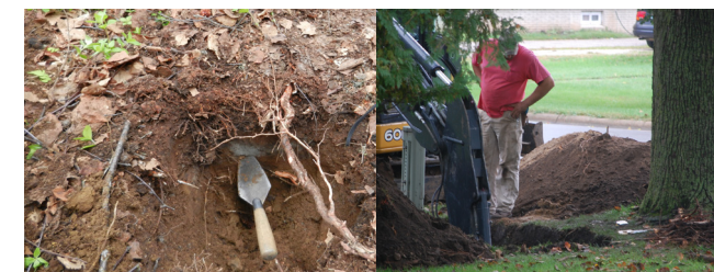
Figur 18: Hvis der graves ved rødder, skal der håndgraves for at begrænse skader på rødderne som vist på foto til venstre. Foto til højre viser et eksempel, hvor der graves med maskine ved rødderne med risiko for store skader på træet.
